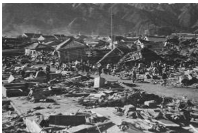
昭和東南海地震の時の尾鷲市内の被害 (写真：太田金典さん)
